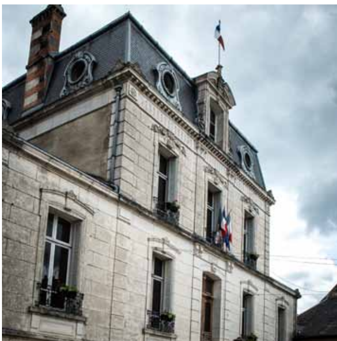
Mairie de Vanvey, 19 e siècle
